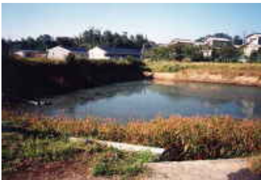
1 0 9 屋島池 (通称 藤田池)
